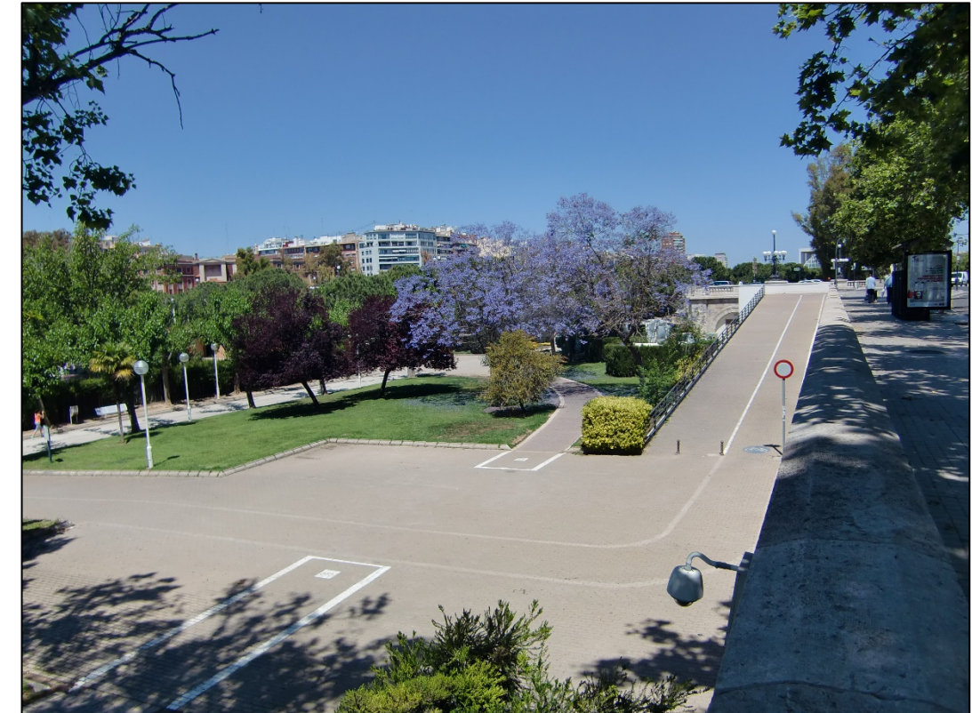
Figura 25. Zona de conexión con el colector del antiguo cauce del Río Turia.
