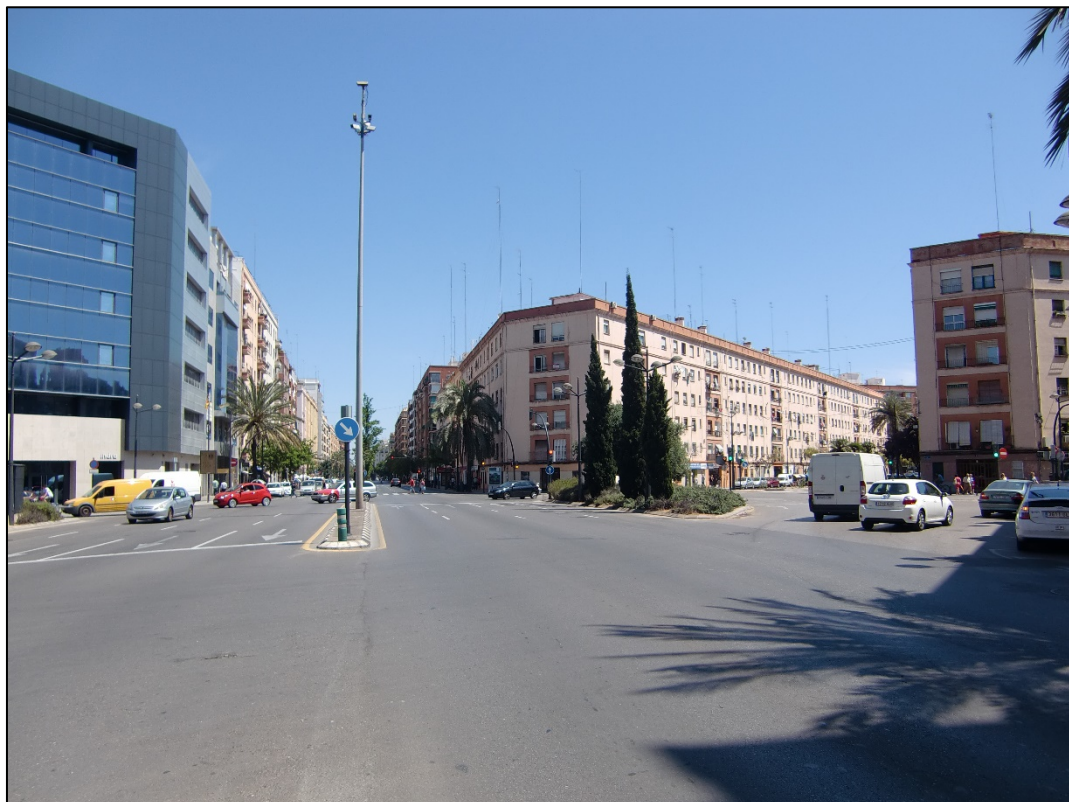
Figura 20. Avenida Cardenal Benlloch - Calle Yecla.
